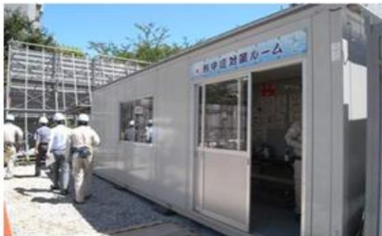
①休憩設備（熱中症対策品を備えた休憩室）
